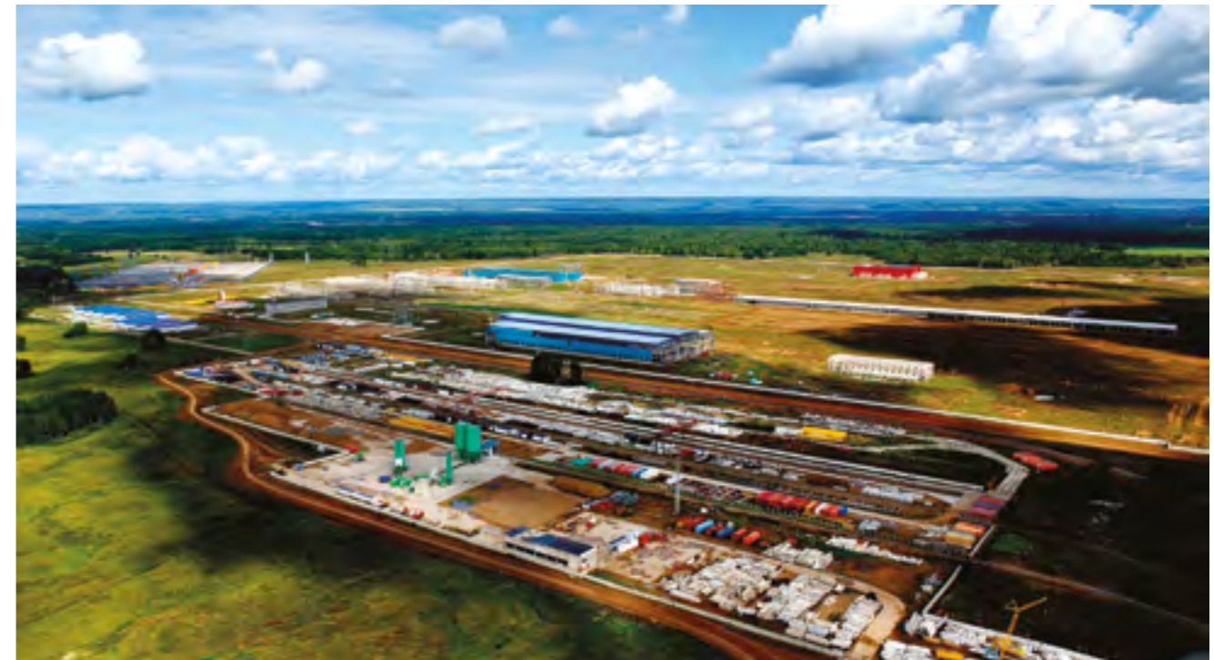
Тайшетский алюминиевый завод, ведется строительство
