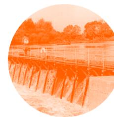
Во время строительства Зырянской ГЭС применялись новаторские технологии: искусственное водохранилище на реке Березовке совместили с системой шлюзов и построили желоб для доставки воды к водонапорным гидроагрегатам.
