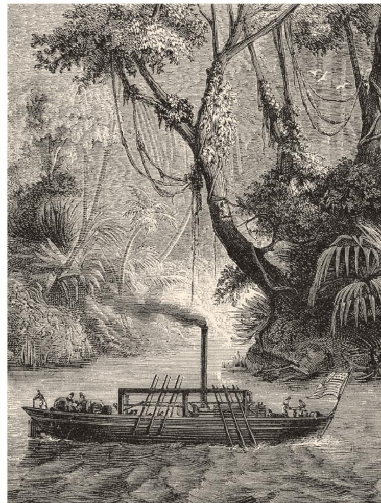
— На судне, испытанном американцем Джоном Фитчем, паровой двигатель приводил в движение весла, повторявшие гребные движения утиных лап. Гравюра. 1850
