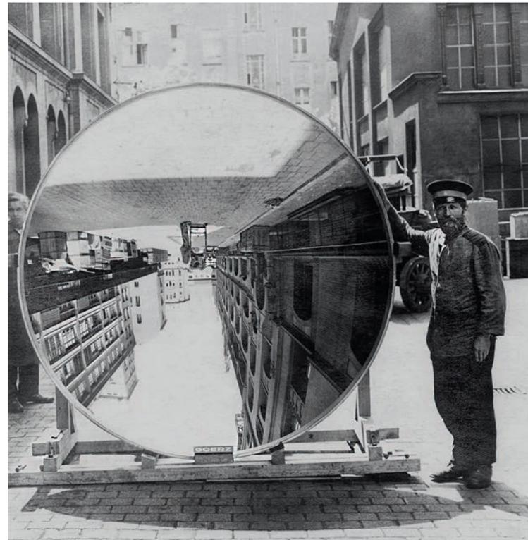
— Стеклопанный параболический отражатель диаметром 2 м. Берлин. 1926
